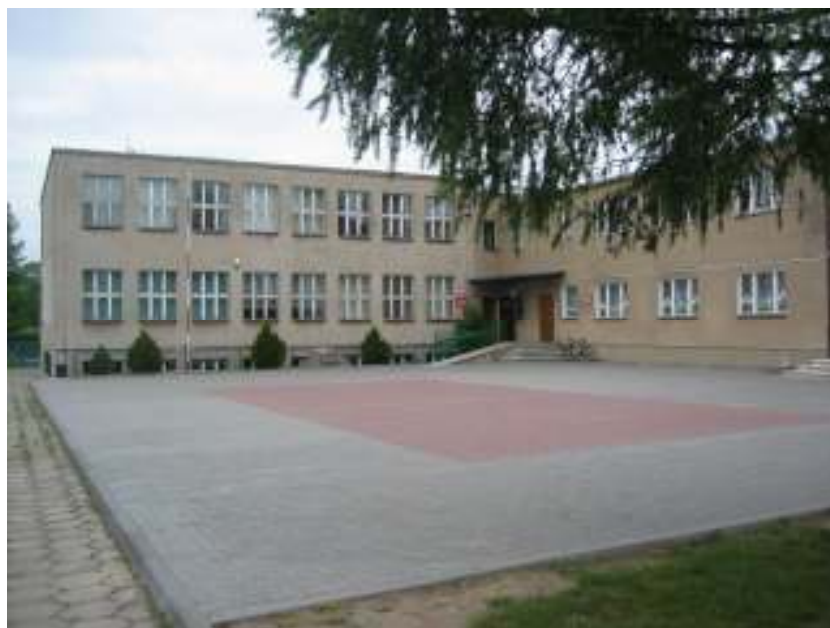
Budynek szkoły i oddziału przedszkolnego w Goniembicach
