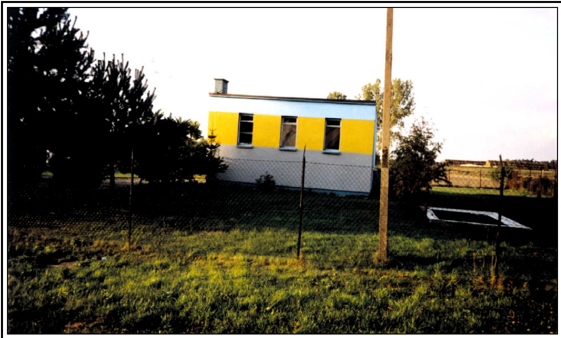
Fot.13 Ujęcie wody Górka Duchowna
