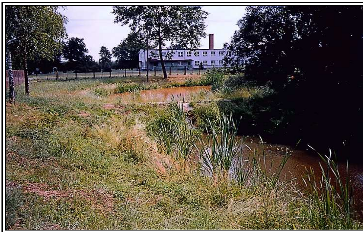
Fot.15 i Fot.16 Przystkolna roślinno-stawowa oczyszczalnia ścieków w Wilkowicach
