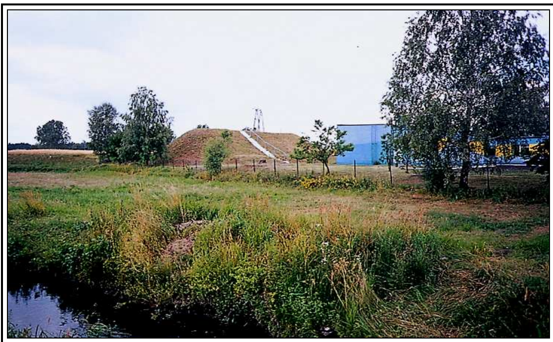
Fot.14 Ujęcie wody Radomicko
