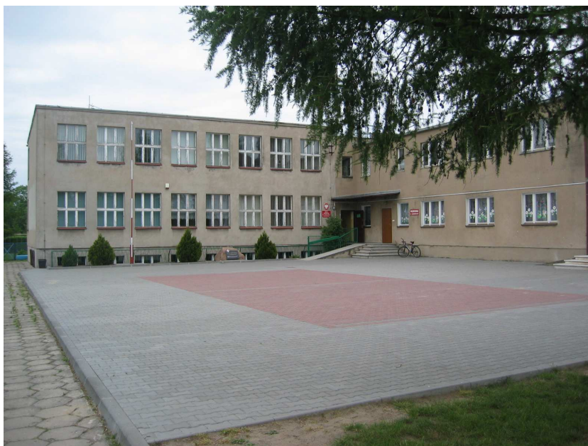
Budynek szkoły i oddziału przedszkolnego w Goniembicach
