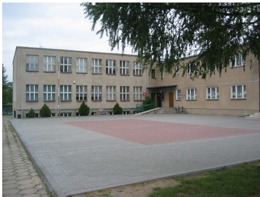
Budynek szkoły i oddziału przedszkolnego w Goniembicach
