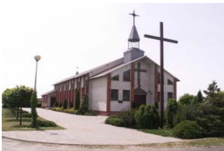
Kaplica p.w. Św. Jadwigi Śląskiej w Lipnie
