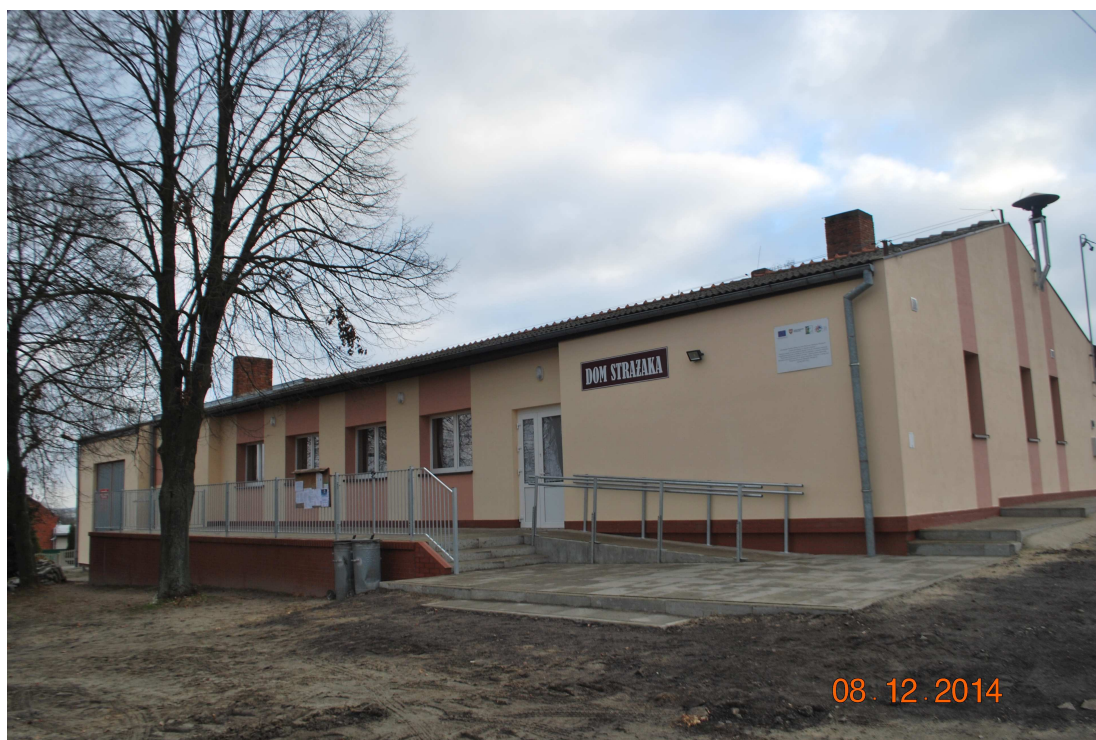
Rysunek 6. Świetlica wiejska wraz z remizą strażacką
